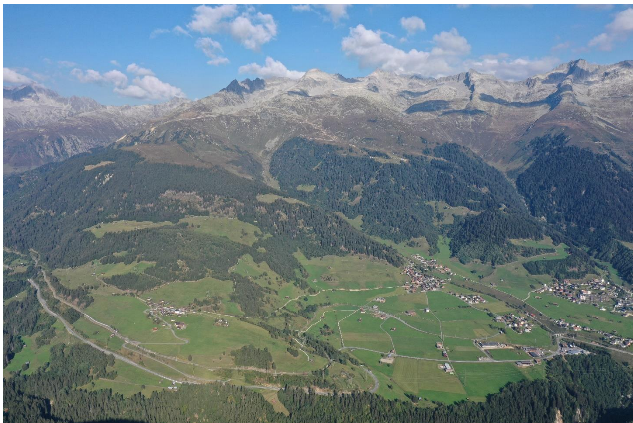
Uauls da protecziun da Ruinas dil Bostg - Prau Sura - Bostg - Val Segnas - Plaun Menisch
