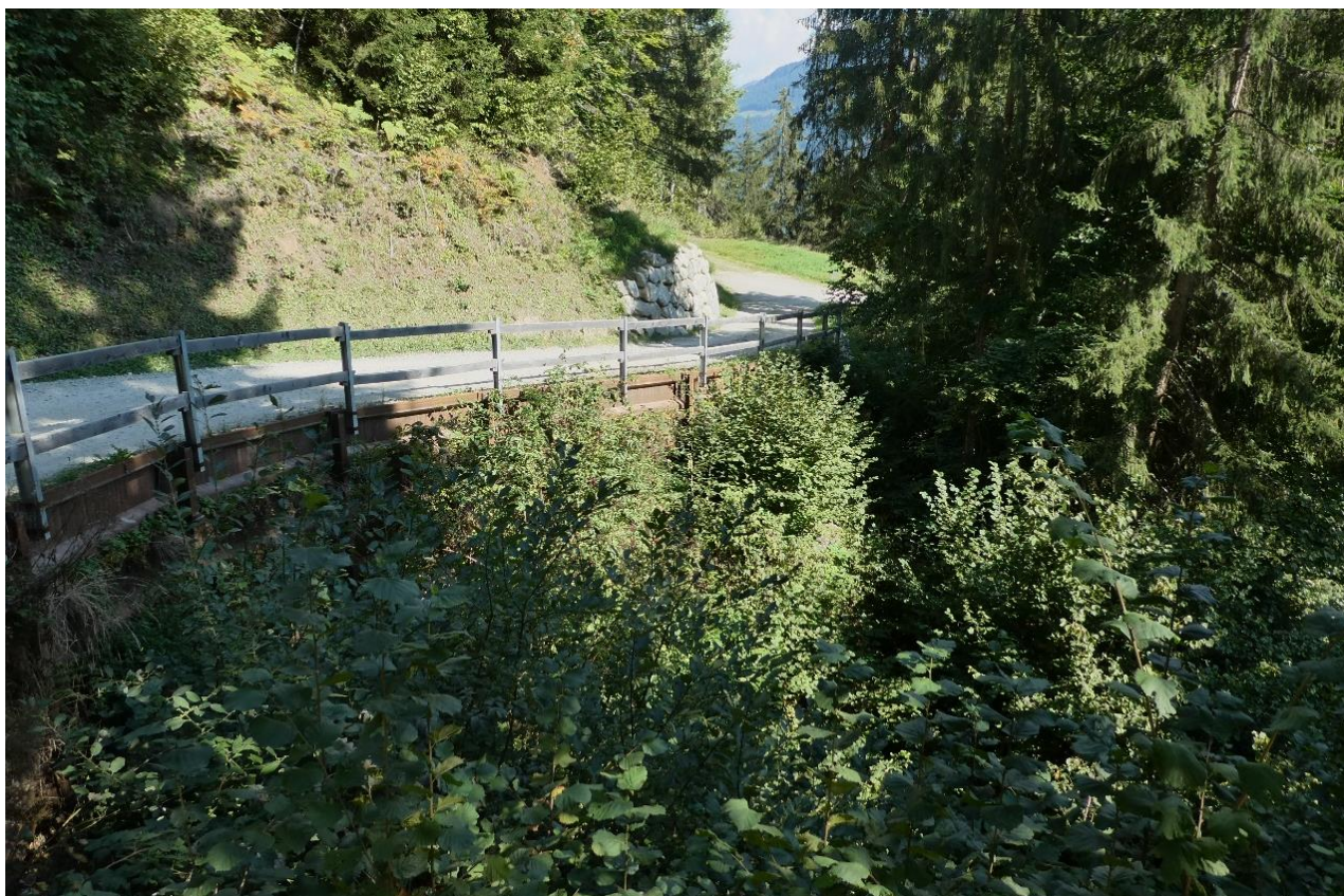
Preits da spundas, sistem en cumbinaziun cun mirs da blocca en betun per minimar scavaments, optimar cuosts e per buca disfar elements stabils el terren. (fotografia exempel via d'ual a Munt, Trun, fotografau treis onns suenter la construcziun)
