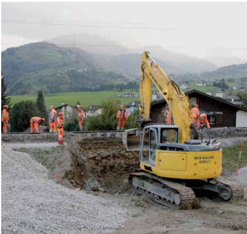
Construcziun dil sutpassadi Chischliun
