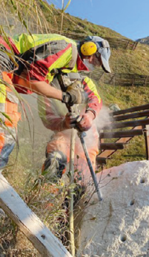
Lavur da dustar crap che ha donnegiau lavineras da fier. Las lavineras ein vegnidas remplazzadas entras il menaschi tecnic
