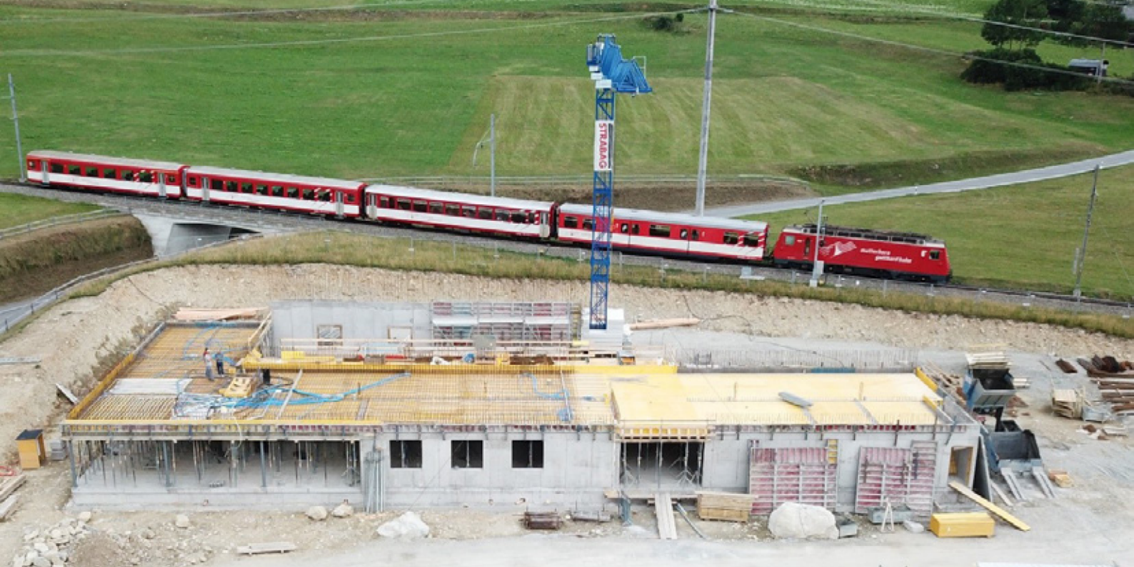
Giger SA: Il baghetg pren fuorma
