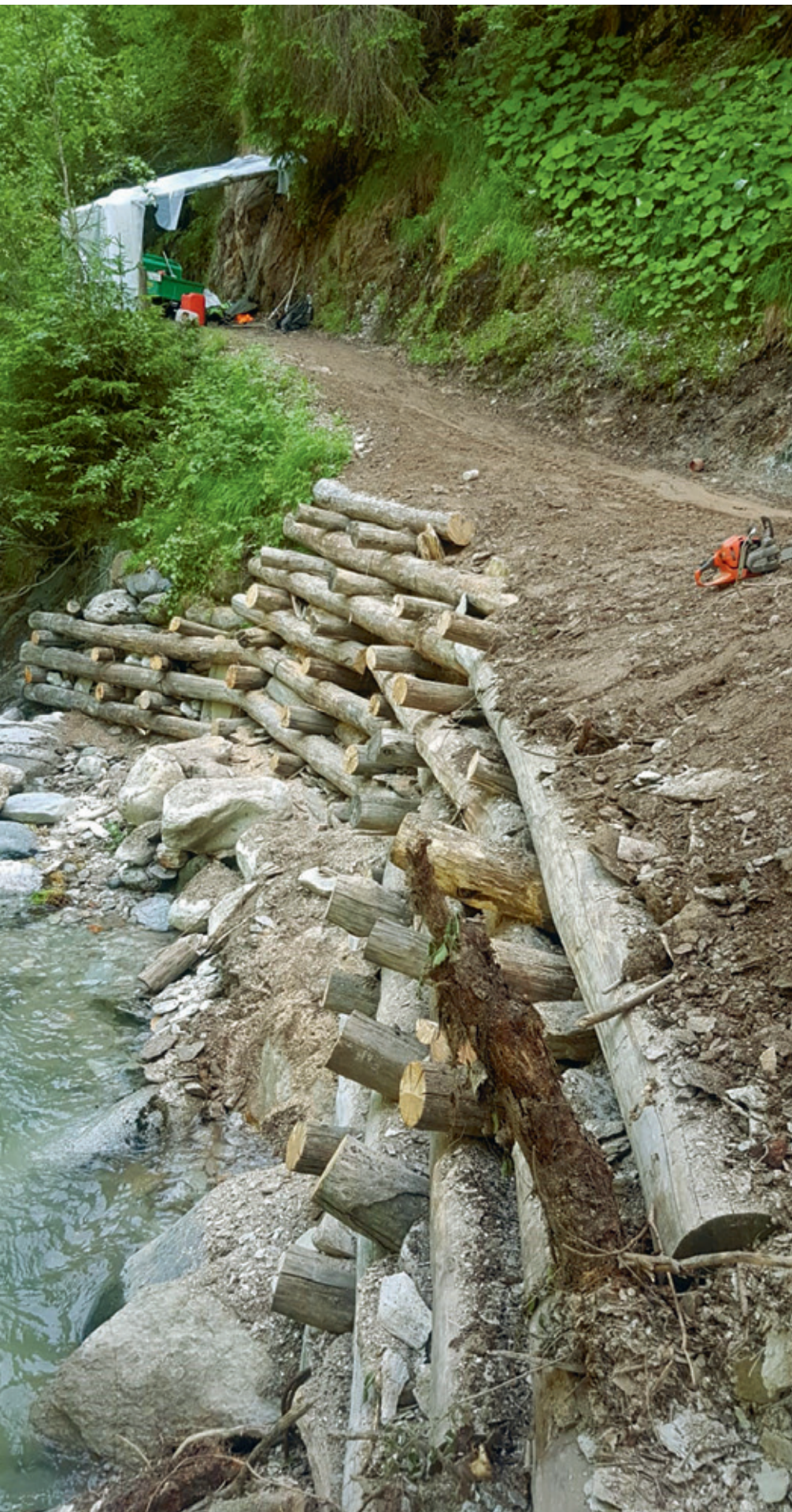
Reconstrucziun dalla senda da viandar a Cufions cun in canaster da lenna
