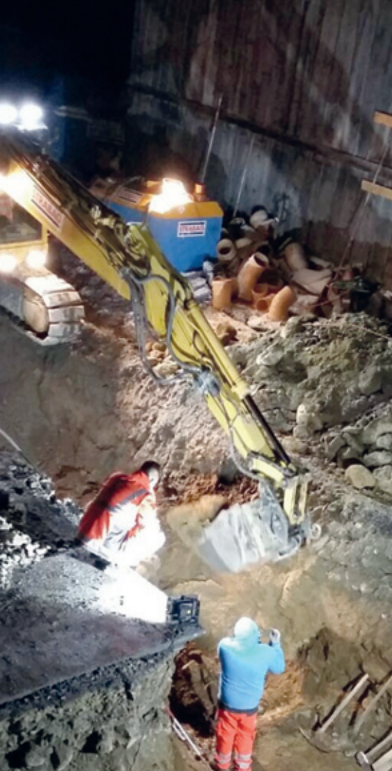
Lavur da notg en connex cun la dislocaziun dalla canalisaziun Via Veglia
