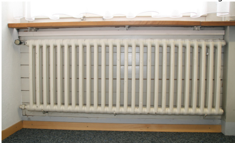
Ils radiaturs dateschan dils onns '60 e ston vegnir remplazzai. Cheutras spargnein nus energia.
