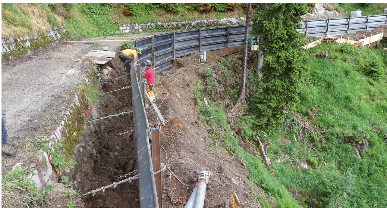
Val Mala, preits montadas. Lavur da buglir e silsuenter emplenir. In mied che basegna transports e scavaments minimals. Ils mirs existents vegnan aschia buca tangai
