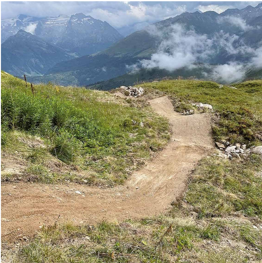
Construcziun da sendas per bikes
